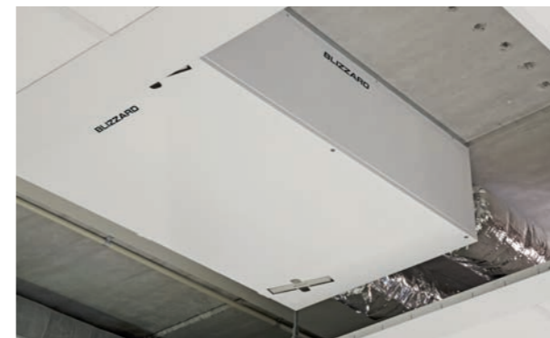
Монтаж вентустановки RS между потолком и подвесным потолком
